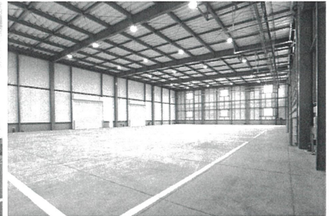
「袖ヶ浦ファクトリー」2期棟内観
