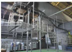
塗装ライン 入念に下地処理し、カチオン電着塗装1回と粉体塗装1回を施します。
